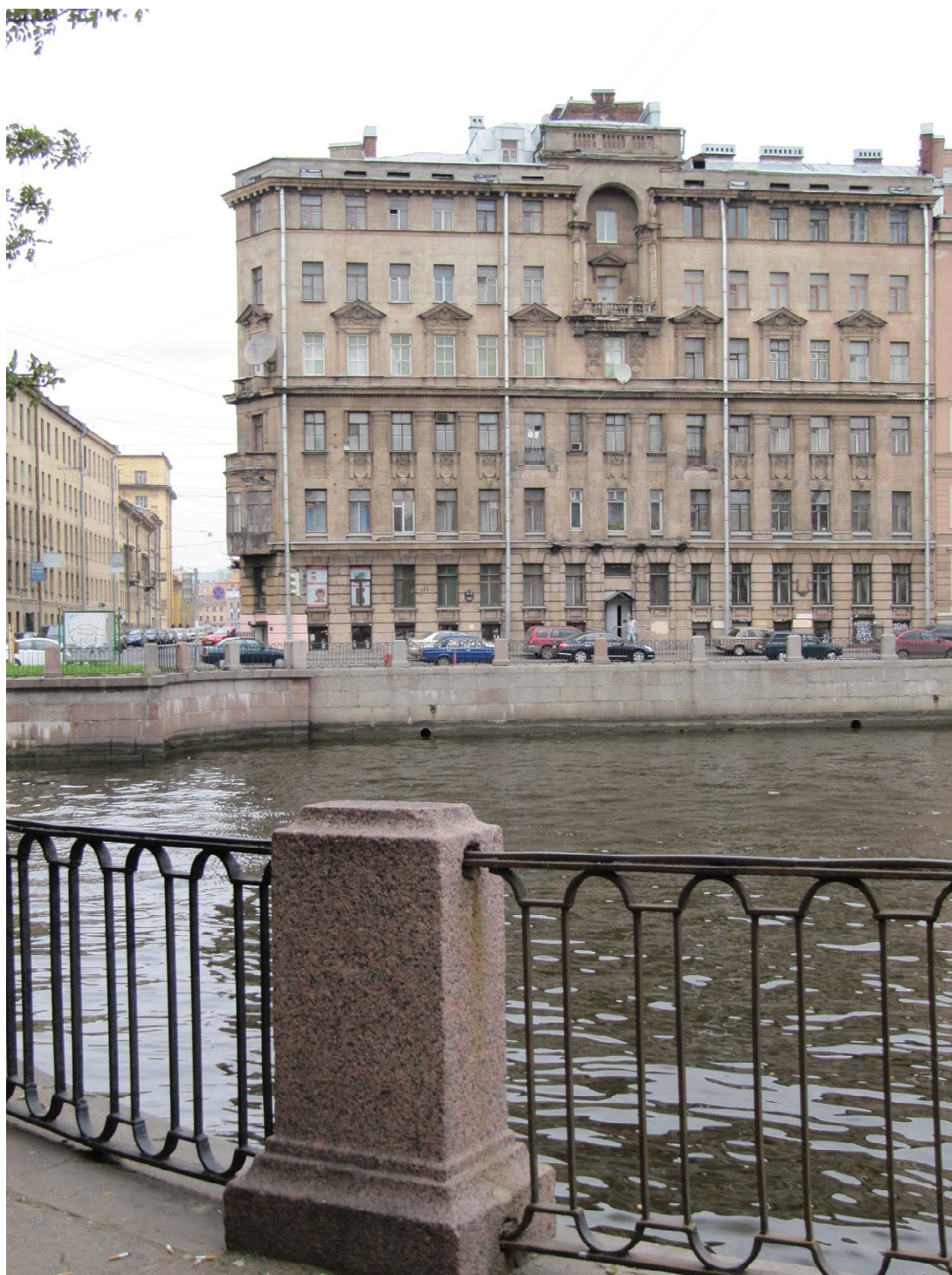
Дом Марголиных в Петербурге на наб. реки Фонтанки, 131. Архитектор А.Л. Лишнеvский. 1914 г. Фото автора. 2010 г.
