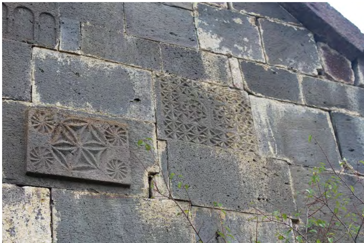
Рис. 14. Резной блок. Южный фасад церкви в Дисеве. XVIII–XIX вв. Фото Е.Ю. Ендольцевой Fig. 14. Carved block. Southern façade of the church in Disev, 18 th –19 th cc. Photo of E. Yu. Endoltseva
